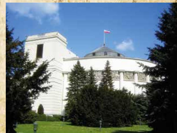
Ryc. 12. Kompleks budynków Sejmu RP (źródło: Wikipedia)
